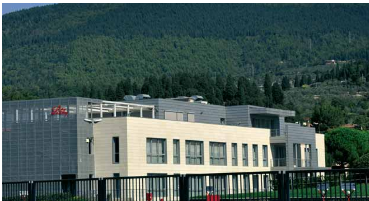
L'edificio P31 dello stabilimento Eli Lilly di Sesto Fiorentino con pannelli orizzontali di tamponamento esterno YTONG
